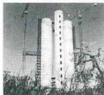
OPERE DI REGOLAZIONE DELLA CONDOTTA CASAMASSIMA-CANOSA (BARI)
