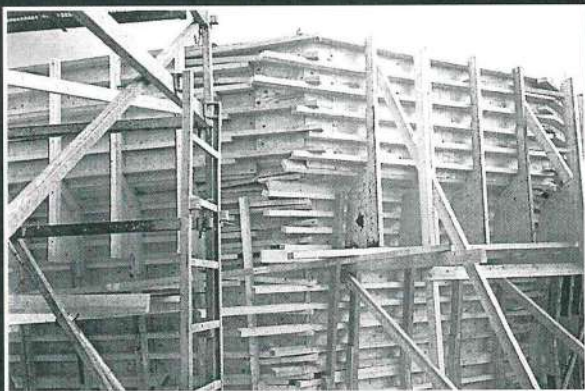
PROSPETTIVA E FASI DELLA COSTRUZIONE
